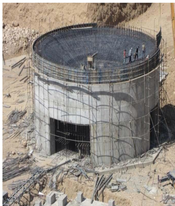
فونداسیون مخزن ۱۲ هزار تنی آهن اسفنجی
