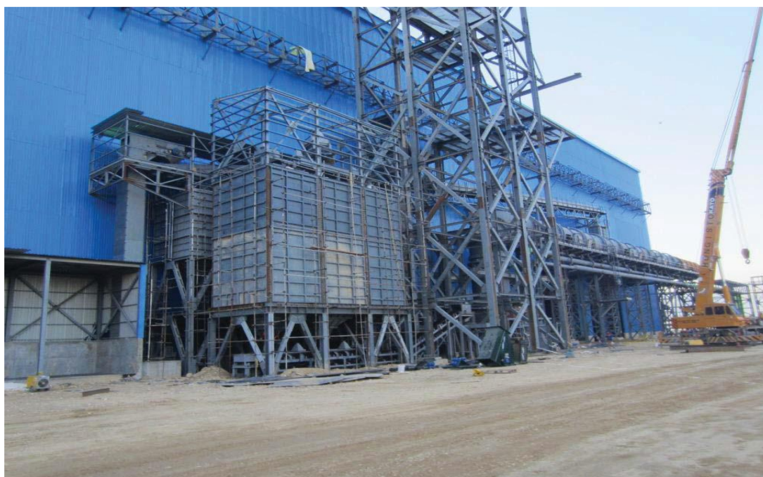
اجرای مخازن ذخیره افزودنی های شارژ کوره EAF به همراه سیستم انتقال مواد
