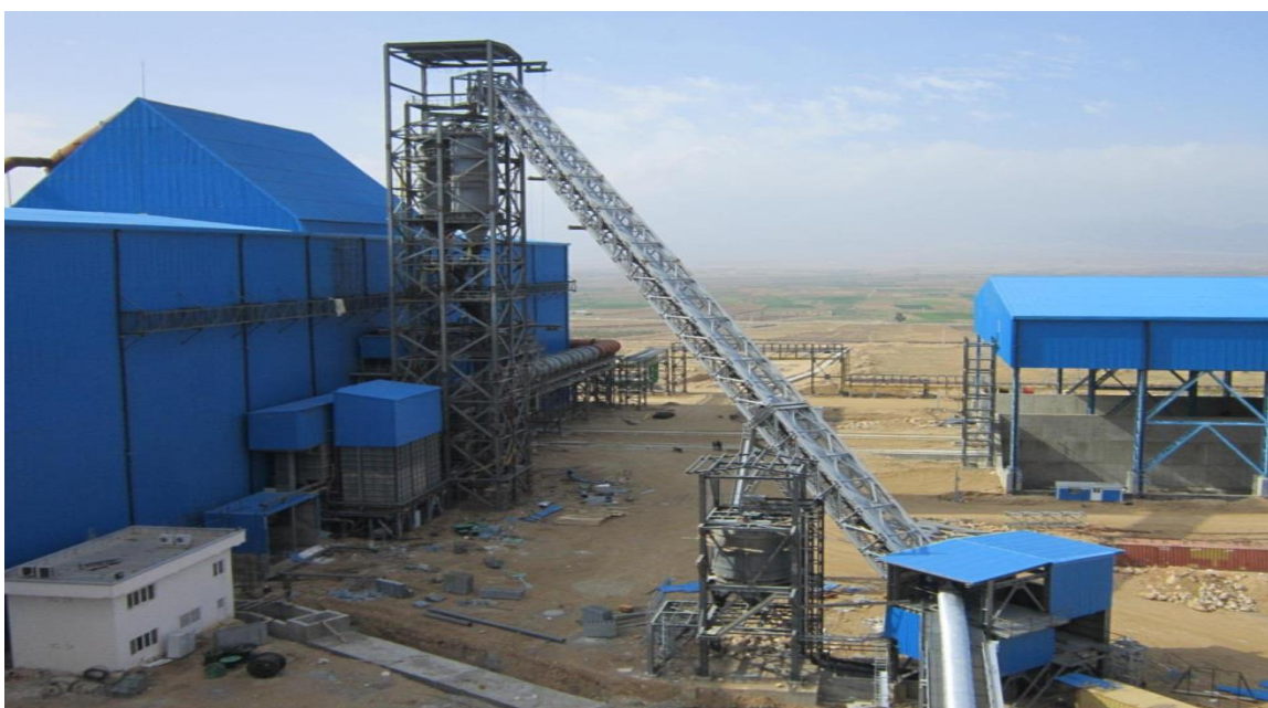
مدل مهندسی نوار سایدوال برای انتقال آهن اسفنجی ذوب آهن پاسارگاد
