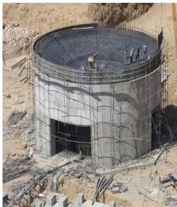
فونداسیون مخزن ۱۲ هزار تنی آهن اسفنجی
