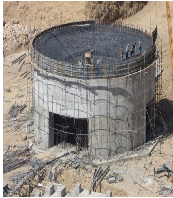
فونداسیون مخزن ۱۲ هزار تنی آهن اسفنجی
